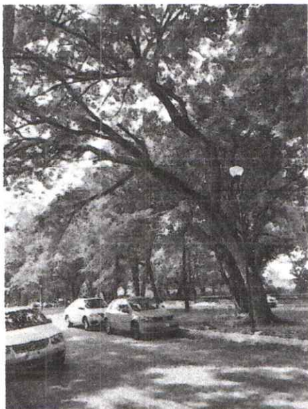
Foto 1. Vista lateral del árbol Samán donde se logra apreciar la inclinación de las ramas obstruyen el cableado.
