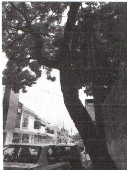
Foto 4. Vista lateral del árbol de Maculis donde se logra apreciar una inclinación prominente del tronco y se aprecia la obstrucción de las ramas en el cableado eléctrico.
